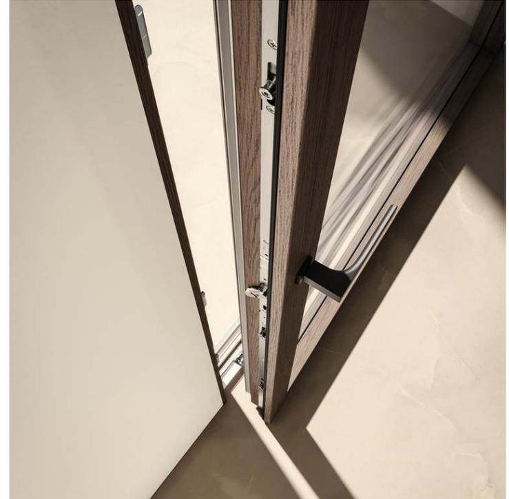
In questo caso l'effetto rasomuro interno obbliga il montaggio di ferramenta con cerniere a scomparsa, dove abbiamo una limitazione dell'apertura a 100°.
